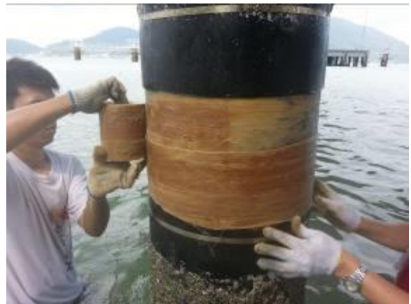
Photo 37: Apply 2 layer STACwrap
